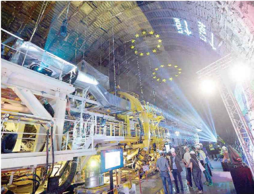
Lo scavo del versante francese a Saint-Martin-de-la-Porte del tunnel ferroviario Torino-Lione
